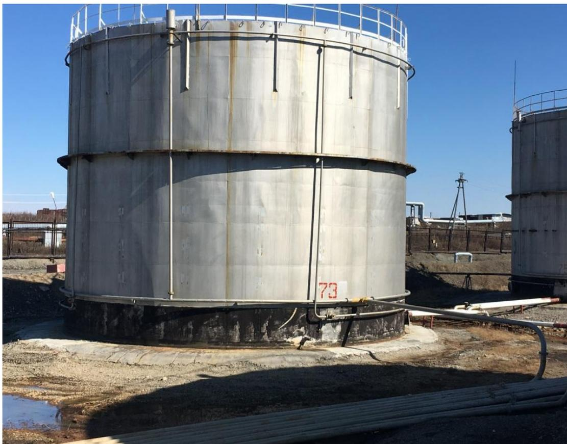
Рисунок 3 - Общий вид резервуара стального вертикального цилиндрического РВС-2000
