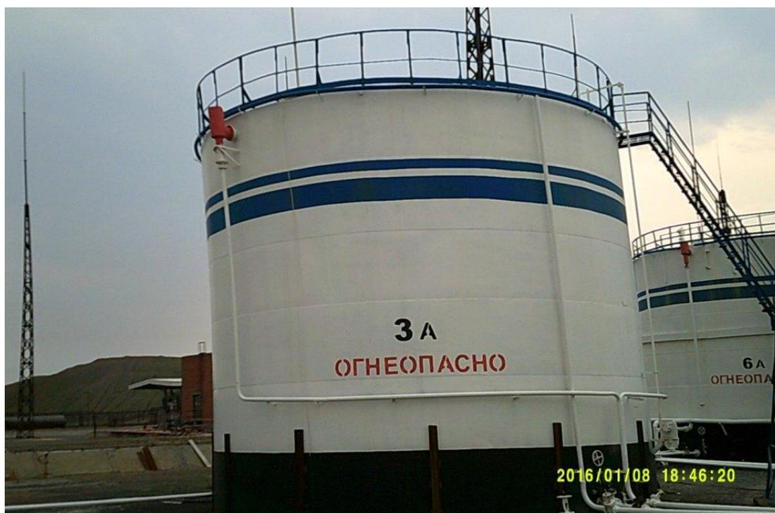
Рисунок 1 - Общий вид резервуара стального вертикального цилиндрического РВС-700
