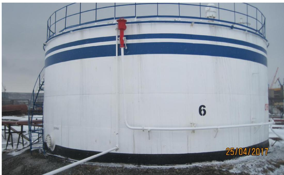
Рисунок 2 - Общий вид резервуара стального вертикального цилиндрического РВС-1000
