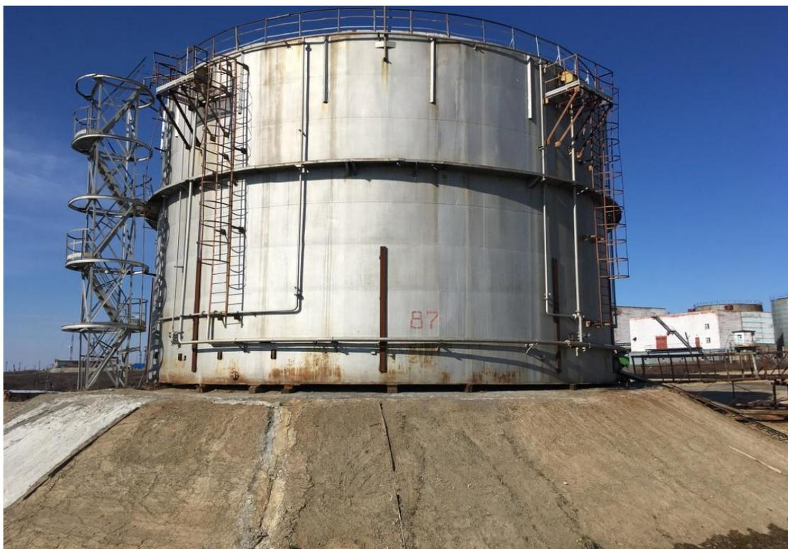
Рисунок 4 - Общий вид резервуара стального вертикального цилиндрического РВС-3000
