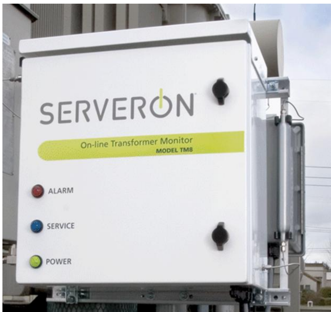
Рис.1 Фотография общего вида хроматографа Serveron модель ТМ8.
