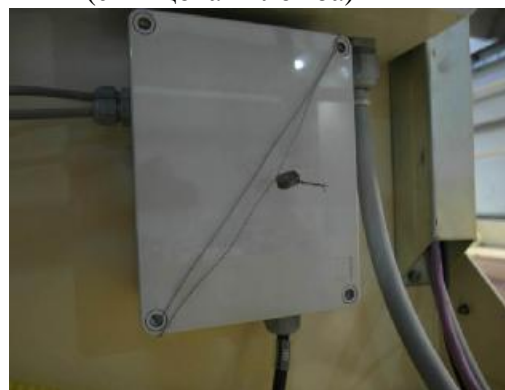
Рисунок 3.4 – Соединительная коробка (свинцовая пломба)
