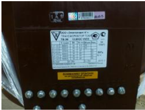
Рисунок 4 - Место нанесения паспортной таблички и поверительного клейма
