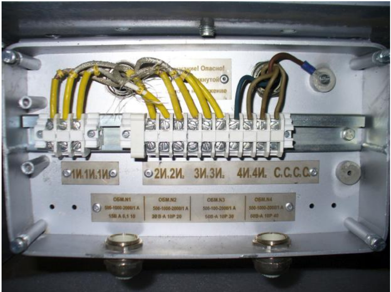
Рисунок 2. Клеммная коробка
