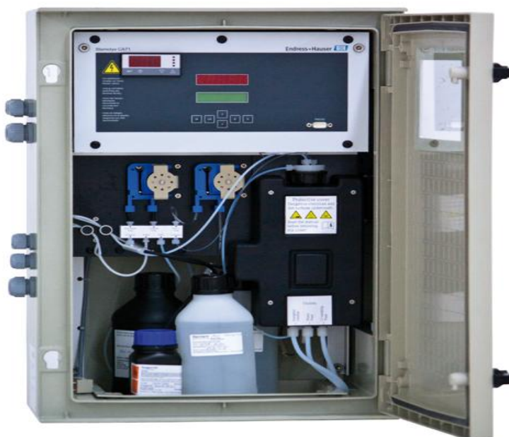
Фотография общего вида анализатора химического потребления кислорода (ХПК) Stamolys CA71COD
