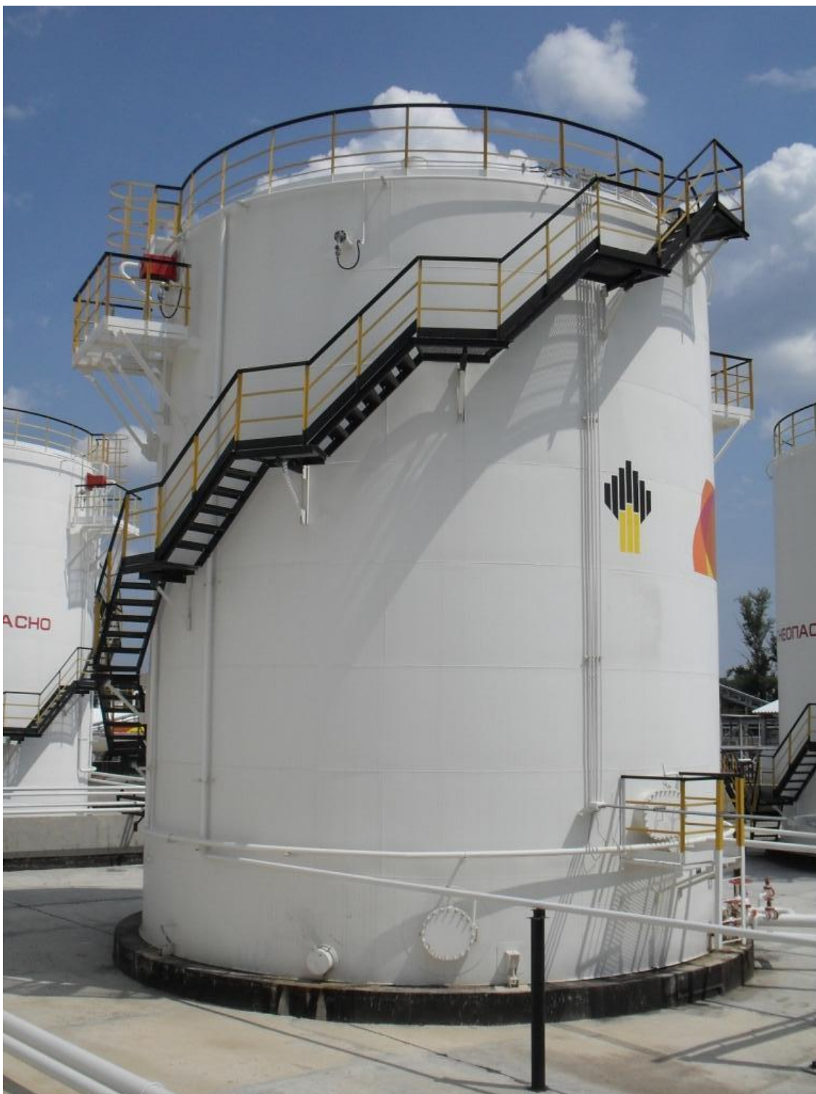
Общий вид резервуара
