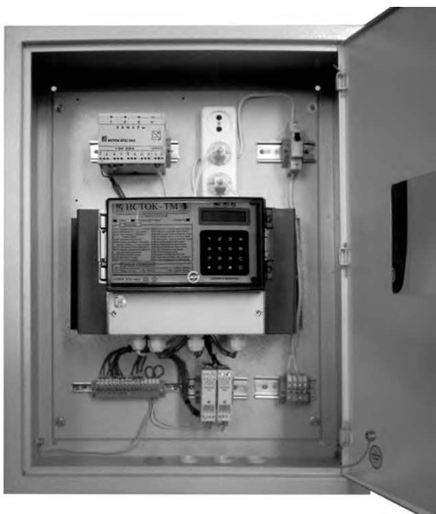
Рис.1 СИ ИСТОК-ГАЗ-03, внутренняя компоновка в монтажном шкафу
