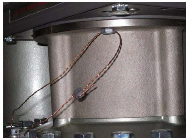
Фото 1.7 – Пломбировка регистратора счетчика модификации LPM-200
